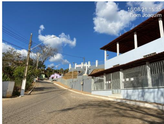
Figura 1 - Iluminação Pública rua do cemitério
