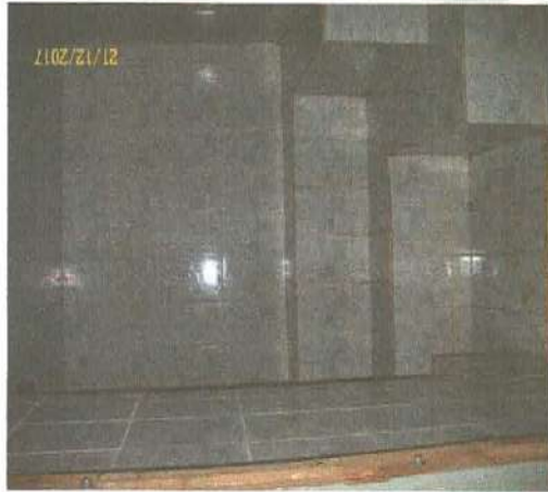
Espaço utilizado como depósito do salão inferior do bar.
